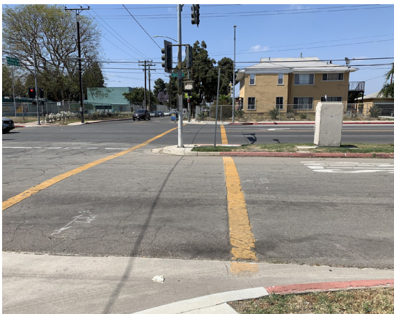
Un cruce de peatones estándar con dos líneas amarillas paralelas en una zona escolar en 120th Street
