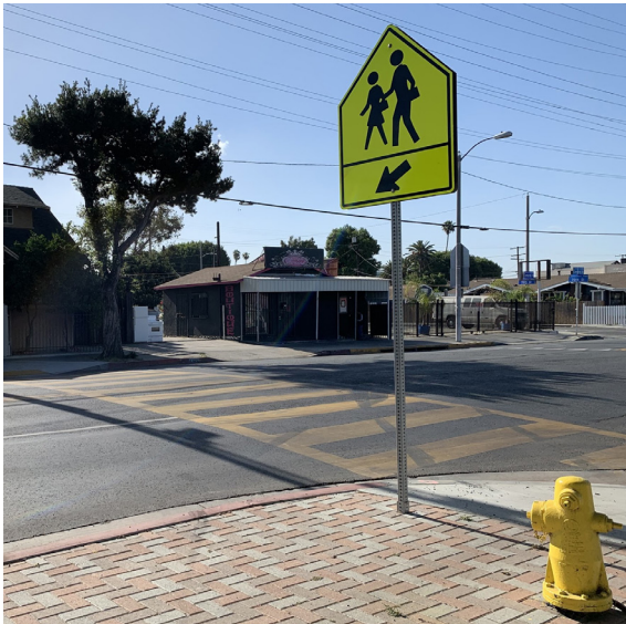
Un cruce de peatones con escalera con rampas de bordillo que cumple con ADA y la señalización de cruce de peatones
