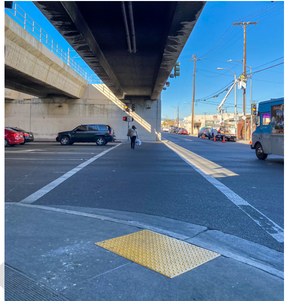
Paso de peatones estándar cerca de una Metro A Line Station.
